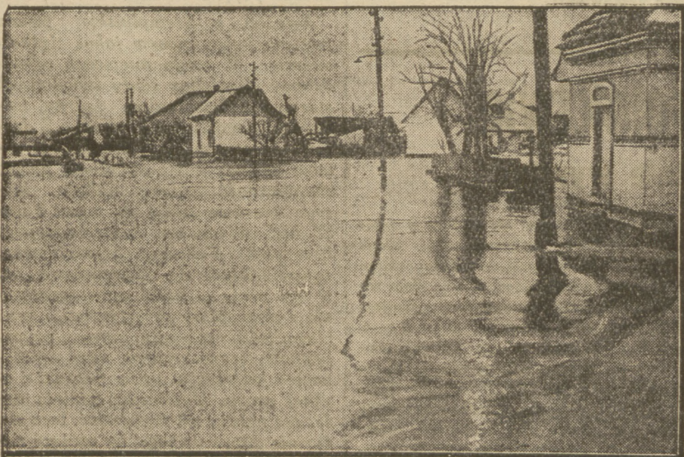
wyrządziła olbrzymie szkody. Około 2.000 domów zostało zniszczonych, drugie tyle znajduje się pod wodą. Przesz- ło 12 tysięcy osób znajduje się bez da- chu nad głową.
