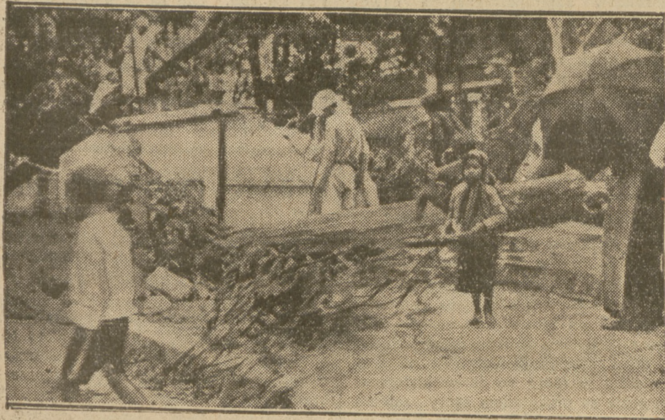
Ulica w Haiphong po przejściu straszliwego huraganu.
