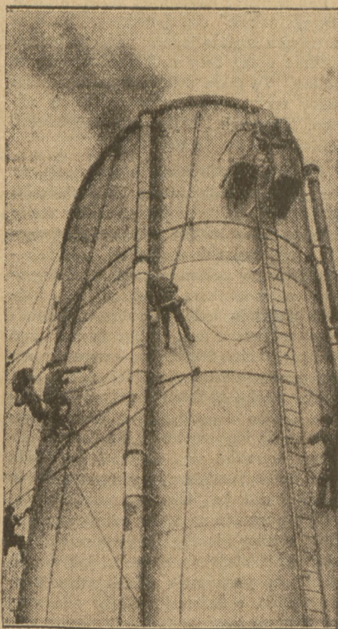
Remont komina okrętowego
