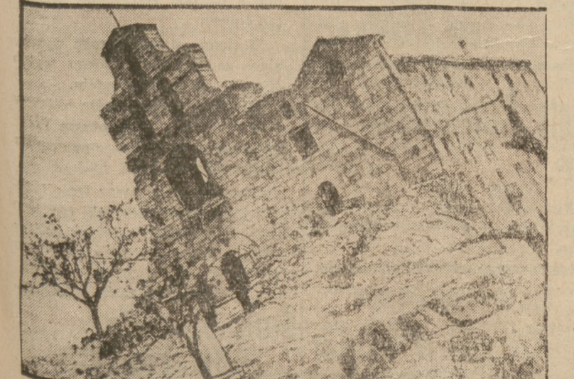
Kościół zniszczony przez faszystów
