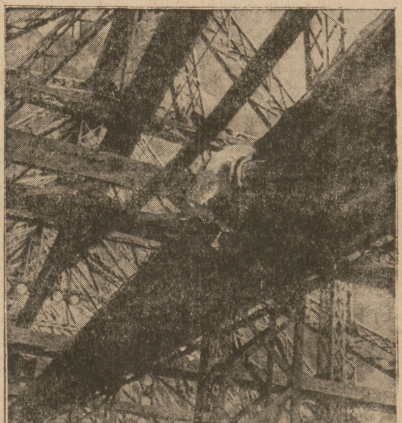
Jednym z cudów wystawy paryskiej będzie stacja telewizyjna. Na naszym zdjęciu montowanie stacji nadawczej na szczycie wieży Eiffa.
