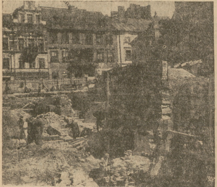
ODSLONIĘTA BASZTA „PROCHOWA” PRZY ZBIEGU ULIC PODWAŁA I NOWOMIEJSKIEJ.
