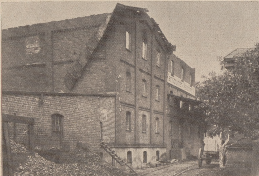
Das zerstörte Mühlengebäude.
