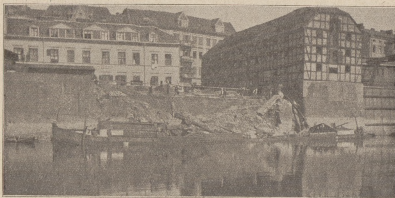
Infolge des heftigen, mit starkem Hagelchlag und stundenlangen ergiebigen Regengüssen verbundenen Unwetters am Sonnabend, den 11. Juli stürzte das Kleemannsche Bollwerk in der Nähe der Wallischebrücke ein: Die beiden Bilder zeigen das eingestürzte Bollwerk in Aufnahmen von den beiden Ufern aus.
