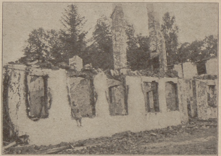
Das zerstörte Pfarrhaus in Laukschken.
