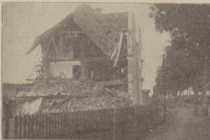
Zerschossenes Haus in Insterburg.
