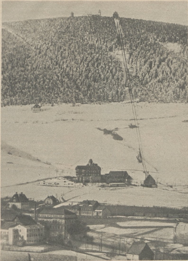
Die erste Personenseil- schwebbahn Deutschlands Am 20. Dez. wurde in Ober- wiesenthal die erste deutsche Seilschwebbahn für Personen- verkehr eröffnet. Die neue Bahn ist 1300 m lang und hat eine Steigung von 300 m. Sie be- fährt bei jeder Fahrt 12 Per- sonen mit Sportgeräten in sechs Minuten von Oberwiesenthal auf den Fichtelberg. — Bild links: Blick auf Oberwiesent- thal. Phot. Atlantic — Bild oben rechts: Die Einweihung der Personenseilschwebbahn in Oberwiesenthal. Photothef
