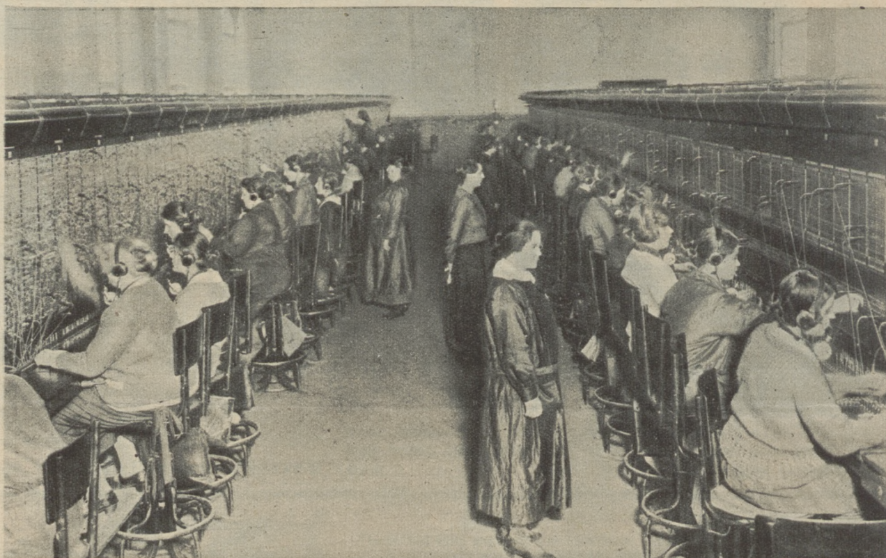
Blick in den Saal der Schaltzentrale, in dem die A-Beamtin den Anruf entgegennimmt und der B-Beamtin weitergibt Hier herrscht im Gegensatz zu der allgemeinen Auffassung eine fast beängstigende Lautlosigkeit
