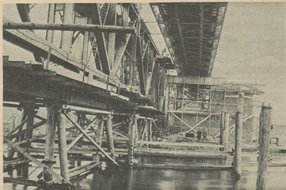
Zu den interessantesten Kapiteln aus dem weiten Gebiet der Ingenieurbaukunst gehört die Auswechslung von Brücken. Unsere beiden Bilder zeigen die Eisenbahnbrücke
