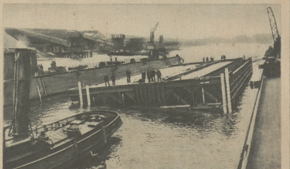
Eines der größten Schleusentore der Welt, das in einer die niederländische Stadt Ijmuiden mit der Nordsee verbindenden Kanalschleufe verwandt werden soll, wurde nach seinem Bestimmungsort übergeführt. Es ist 53,5 Meter lang, 8,4 Meter breit und 20,4 Meter hoch und hat ein Gewicht von ungefähr 1 Million 200 000 Kilogramm. Atlantic
