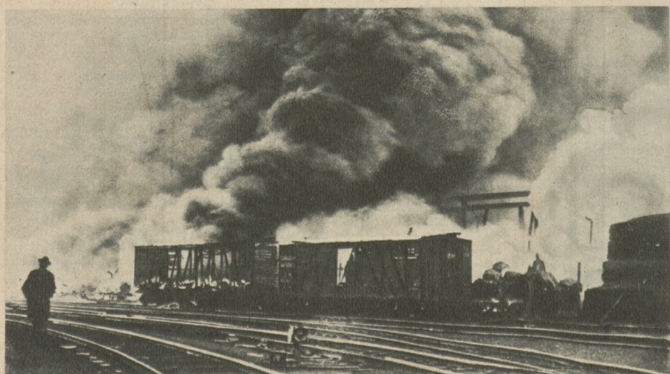
Ein großer Brand im Hafen von New York. Die Anlagen der Pennsylvania-Eisenbahn mit allen Lagerhäusern brannten nieder Sennede
