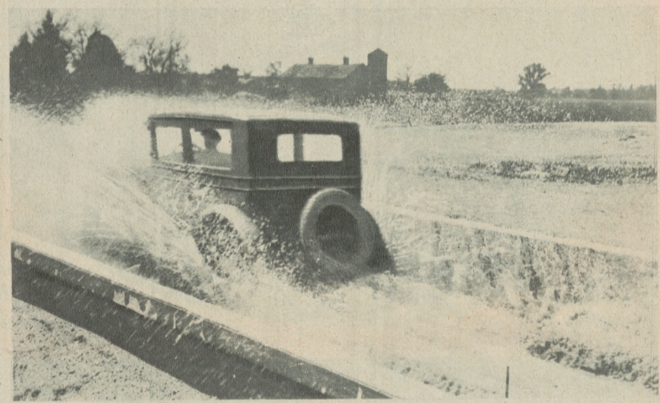
Die Wasserprobe. In Amerika wird angestrebt, Autos so herzustellen, daß sie ohne Betriebsstörung auch durch tieferes Wasser fahren können. Man hat zu diesem Zwecke Straßen mit Wassergräben angelegt, die von den Autos durchfahren werden müssen, um sie so auf „wasserdicht“ zu prüfen. Atlantic
