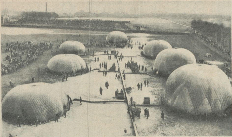
Von der Vorbereitung zum Ausschheidungskfliegen für das Gordon-Bennet-Rennen. Die Ballone wurden in Gelfentkirchen zum Aufstieg gefüllt; die am Erdboden liegenden Gasrohre, die den Ballonen das Gas zuführen, sind deutlich sichtbar. Das Gordon-Bennet-Rennen findet in diesem Jahre am 5. Juni in Detroit (Michigan) statt. Photo: Union
