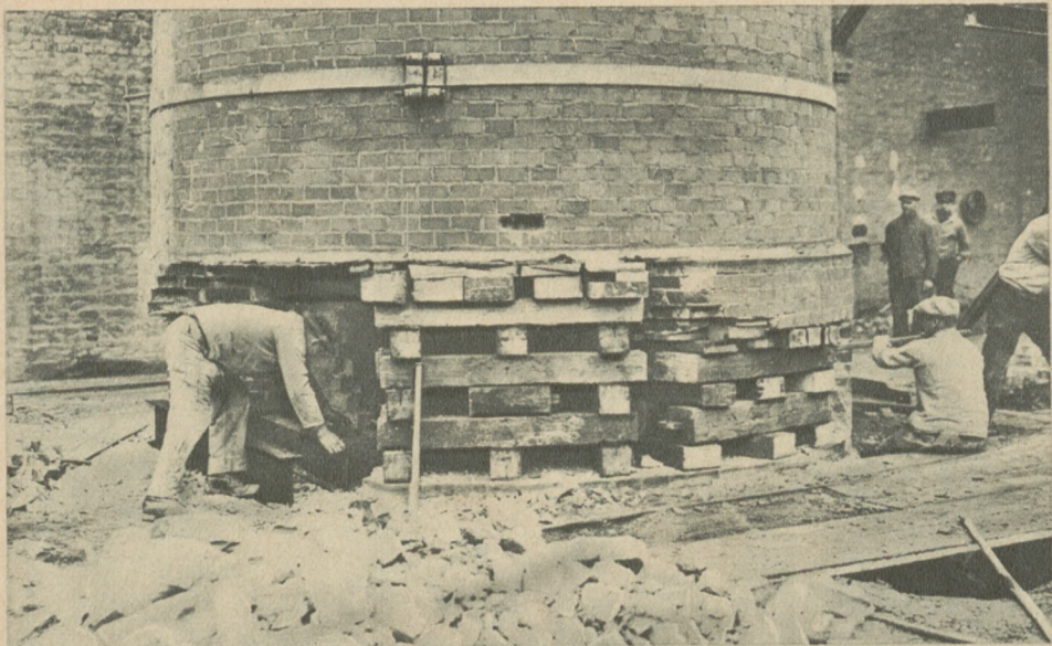
Eine neue Art, überflüssige Fabrikshornsteine umzulegen. Das Fundament des Schornsteines wird teilweise ausgestemmt und das Mauerwerk mit Holzbalken gestützt. Das Holz wird angezündet und nach Verkohlung der Balken stürzt der Schornstein um Schüke
