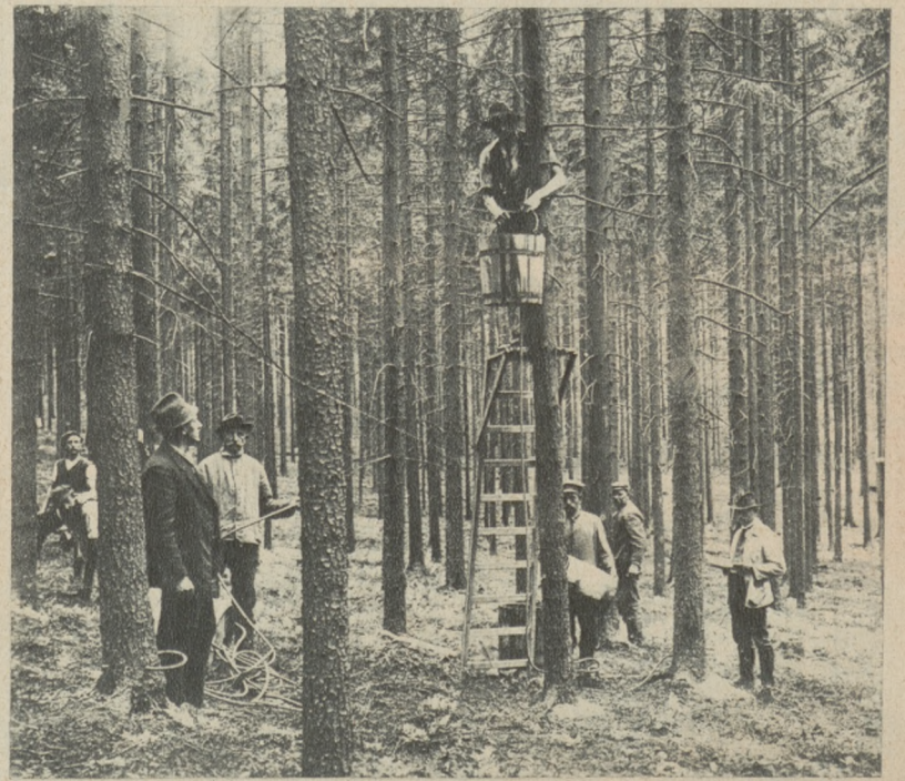
Die Farbe oder das Imprägnierungsmittel wird aus einem hochgehängten Behälter in die Bohrlöcher des lebenden Stammes eingelassen
