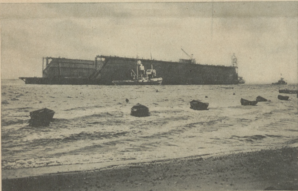
Reparationslieferungen ohne Ende. Das oben abgebildete 25000-Tonnen-Schwimmdock, auf der Vulkanwerft in Hamburg erbaut, wurde an Frankreich geliefert Eberth
