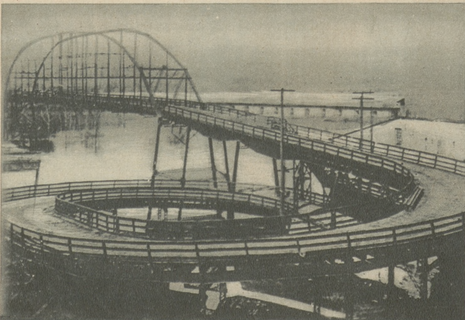
Eine Spiralbrücke bei Hastings in Amerika. Das Südende der Brücke mußte wegen besserer Verteilung des Schwergewichts in Kurven gebaut werden
