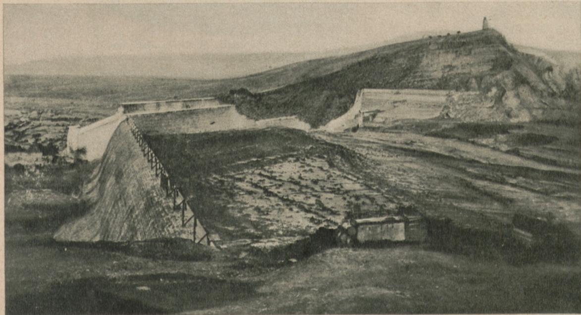
Die Katastrophe von Mostaganem in Amerika. Durch den Bruch des großen Staudamms von Peregauz stürzten die Wassermassen des dahinterliegenden Stausees mit einem Male über die Stadt Mostaganem, in der sie ungeheuerliche Verwüstungen anrichteten. — Blick auf die Bresche in der Mauer des leergelaufenen Stausees, durch die der Fluß seinen Weg nahm. Der eigentliche Abfluß des Stausees geht über die Wehrmauer links S. B. D.
