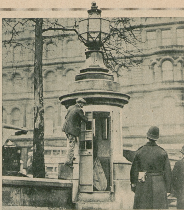
Die Gefängniszelle auf der Straße. An einem verkehrsreichen Platze Londons wurde ein fester Turm aus Granitplatten hergestellt, der der Polizei im Falle von Unruhen zur Überwachung wichtiger Straßenkreuzungen dienen soll. — Der Turm steht in direkter telephonischer Verbindung mit der Leitung der Polizei und soll gleichzeitig dazu benutzt werden, Festgenommene so lange zu beherbergen, bis sie vom Polizeiwagen abgeholt werden Ditch: Fr. 3.
