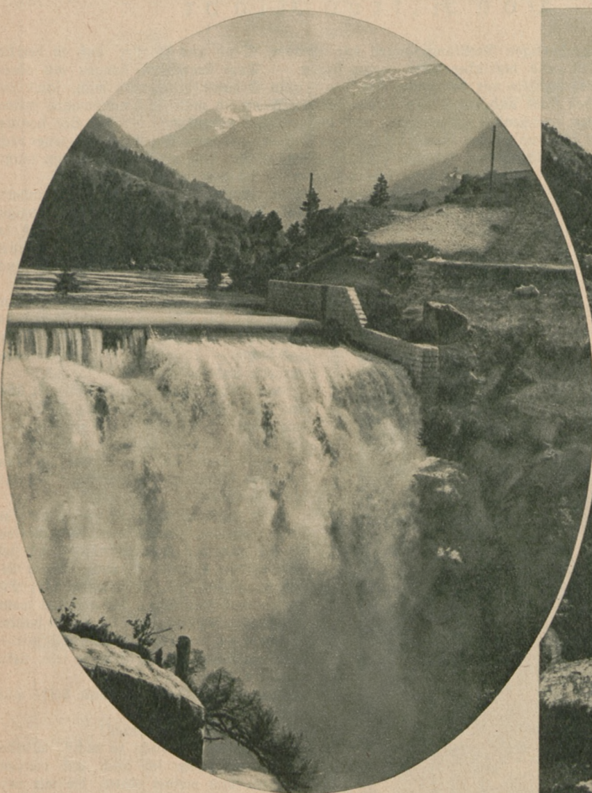
Staubeden am Pfaffenprung für das Kraftwerk Amsteg, das die elektrische Kraft für die Gotthardlinie liefert. Die Staumauer ist 32 Meter hoch, 35 Meter lang. Das Becken faßt 200 000 Kubikmeter Wasser
