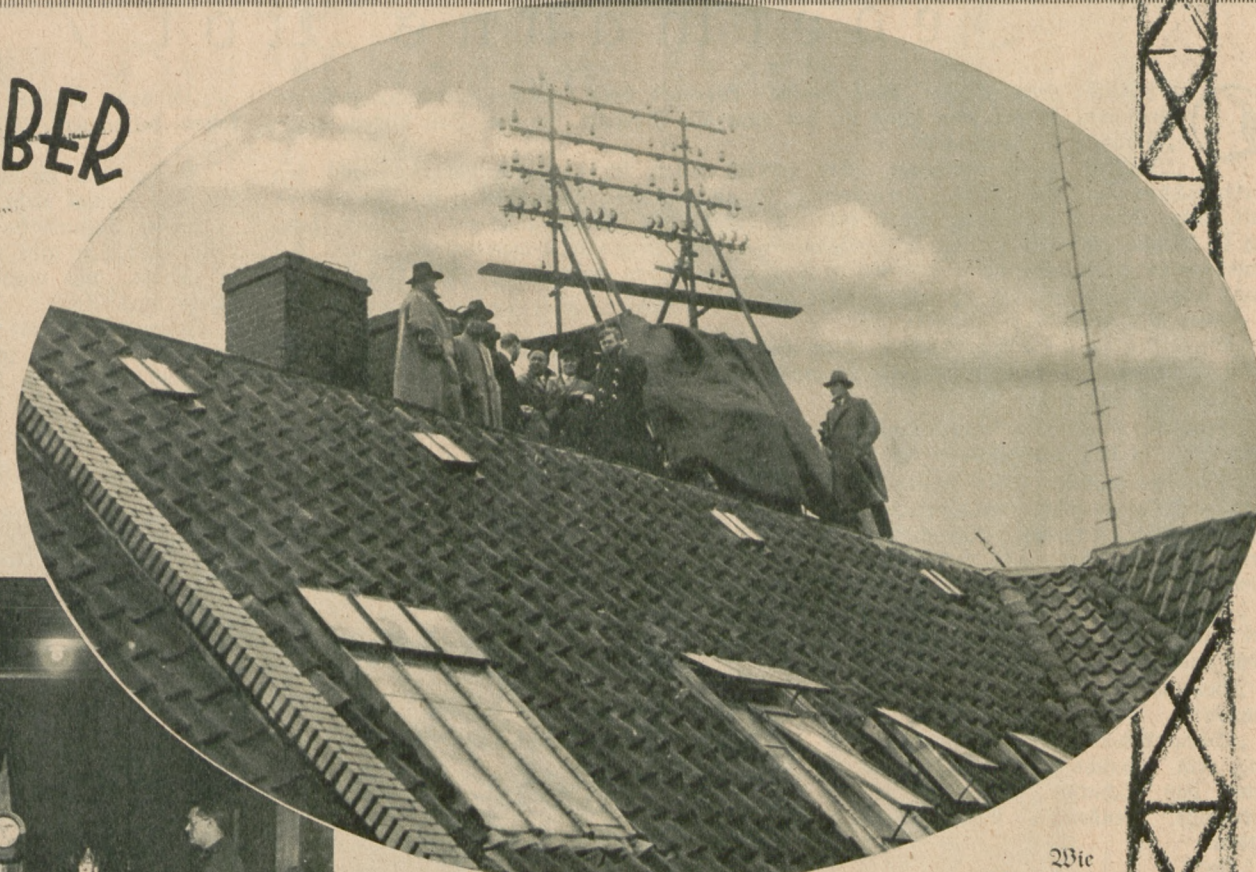
Wie der Rundfunk der Reichshauptstadt den kürzlichen Besuch des „Graf Zeppelin“ erwartete. — Die Abhör- und Sprechstation auf dem Dach des Berliner Funkhauses, die die Verbindung mit dem Luftschiffe vermittelte
