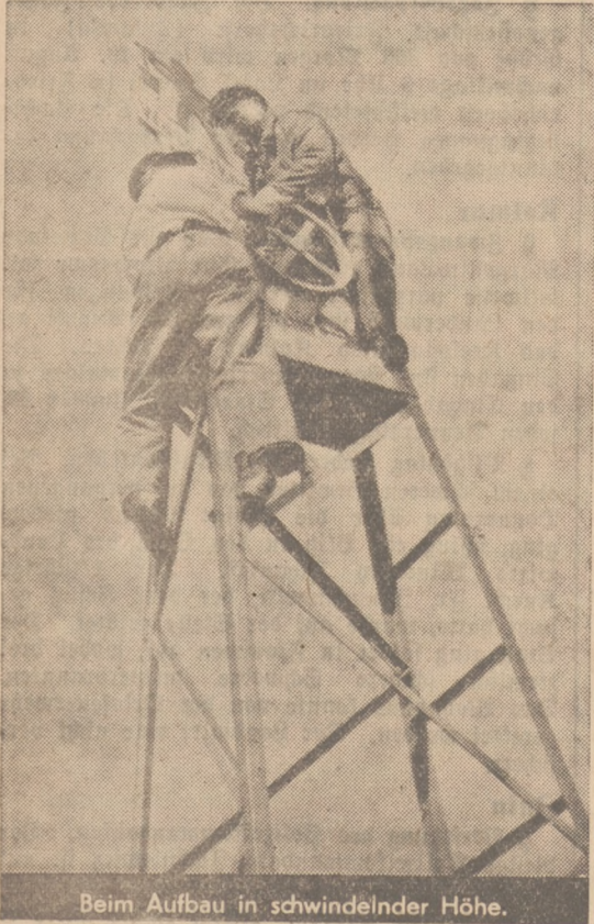
Beim Aufbau in schwindelnder Höhe.
