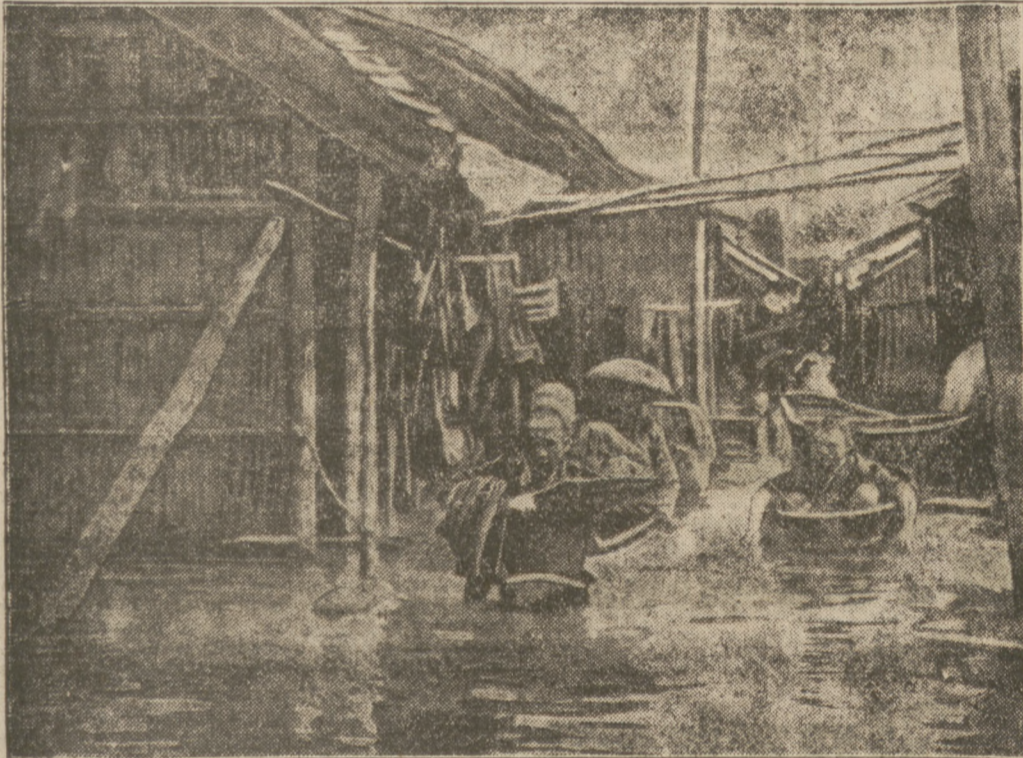
Die zerstörbaren Ueberschwemmungen in China
