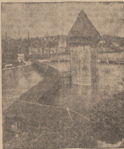
Der achteckige Wasserturm mit der überdachten Kapellbrücke in Luzern.
