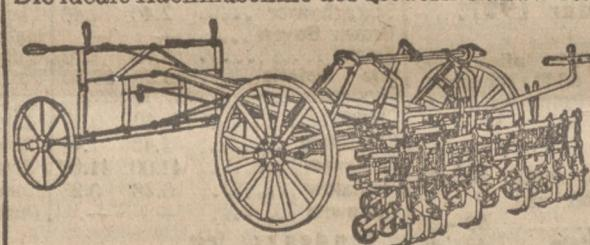
Für alle Bodenarten, auch schwersten Lehm geeignet. Absolut sicheres Eindringen der Hackmesser durch die neue patentierte Abriegelung des Hackrahmens.
