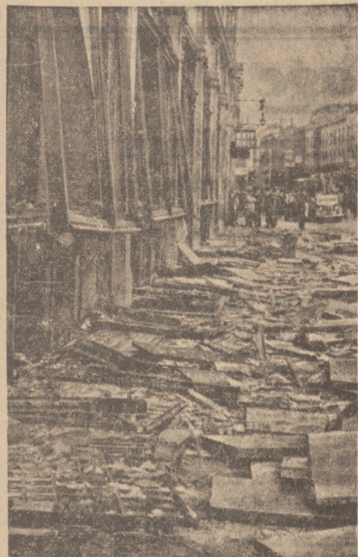
Immer neue Explosionen
