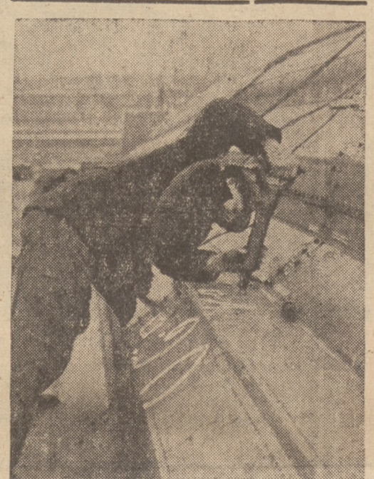
Mit dem Niethammer auf dem Dach Stahlbauer bei der Montage des Stahlbaches einer weitgespannten Halle.
