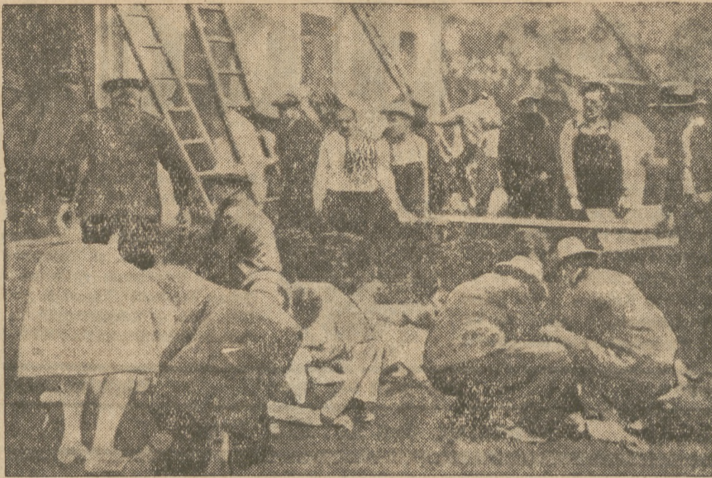
Die Rettungsarbeit bei der Clevelander Katastrophe.
