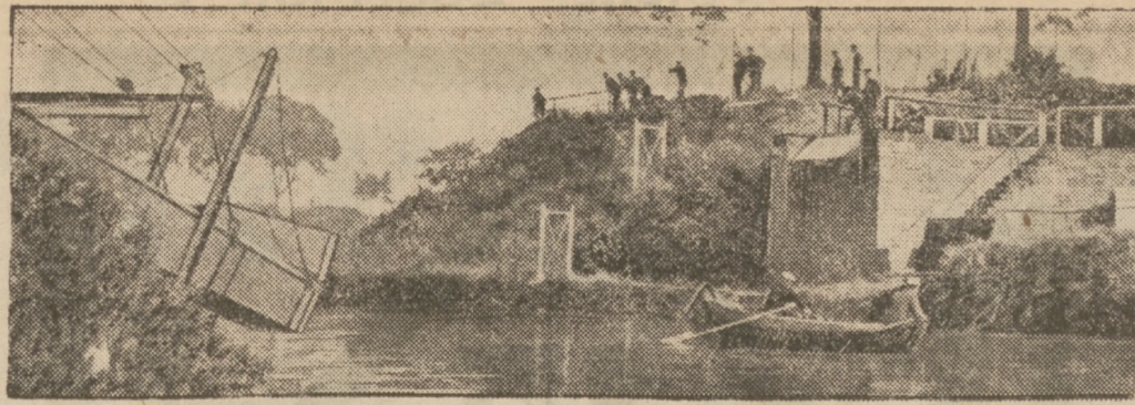
Von der Brückentatastrophe in Koblenz.
