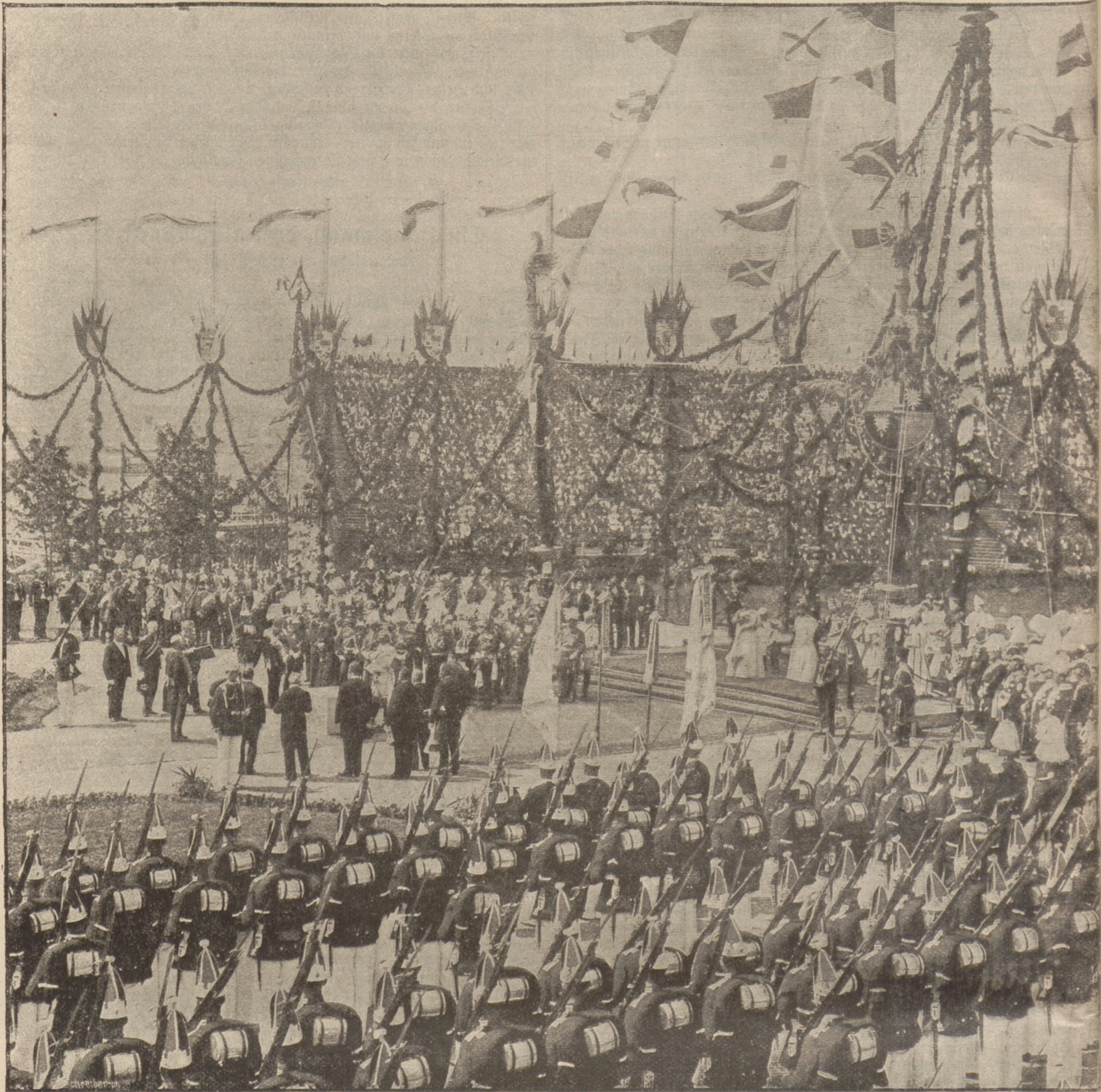
Die Einweihung des Kaiser-Wilhelms-Kanals: Die Schlusssteinlegung in Goltzenau. Nach einer Original-Aufnahme. (Mit Text.)
