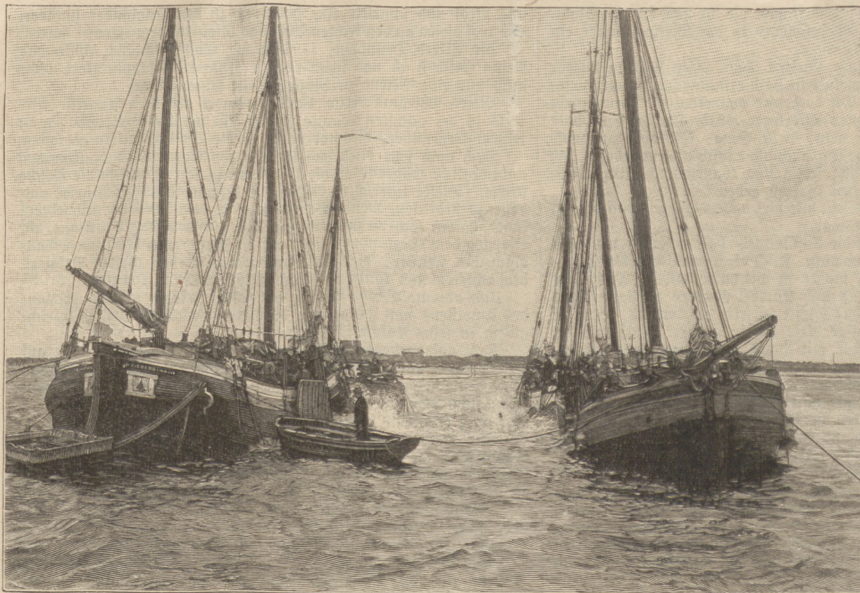
Verfenken eines Senkstücks. (Mit Text.)
