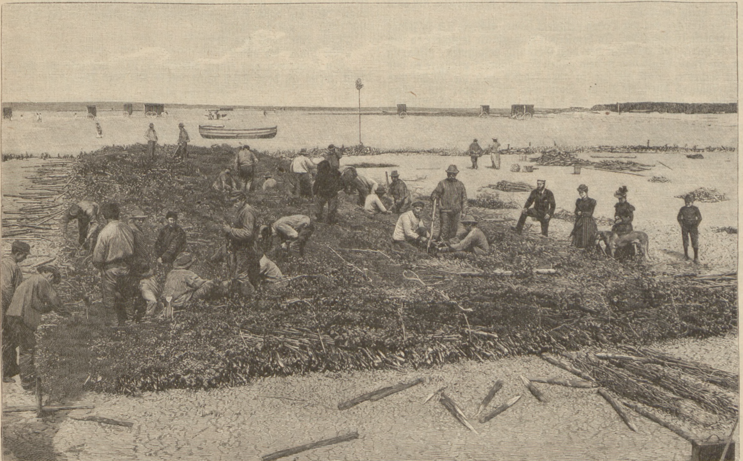
Arbeiten zur Erhaltung der Helgoländer Düne: Herstellung eines Sandkastles. (Mit Text.)
