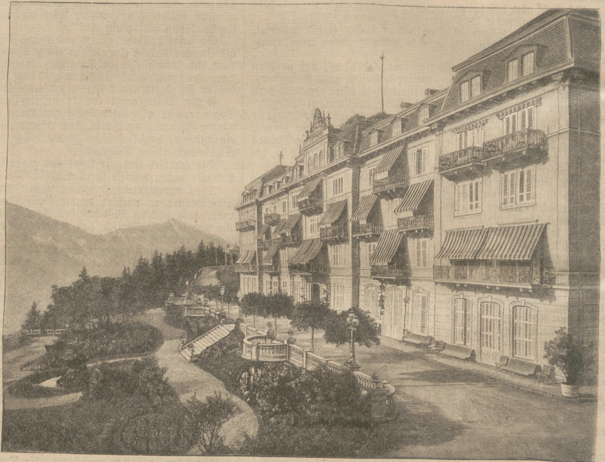
Das abgebrannte Hotel Aegenstein oberhalb Brunnen am Bierwaldstätter See. (Mit Text.)
