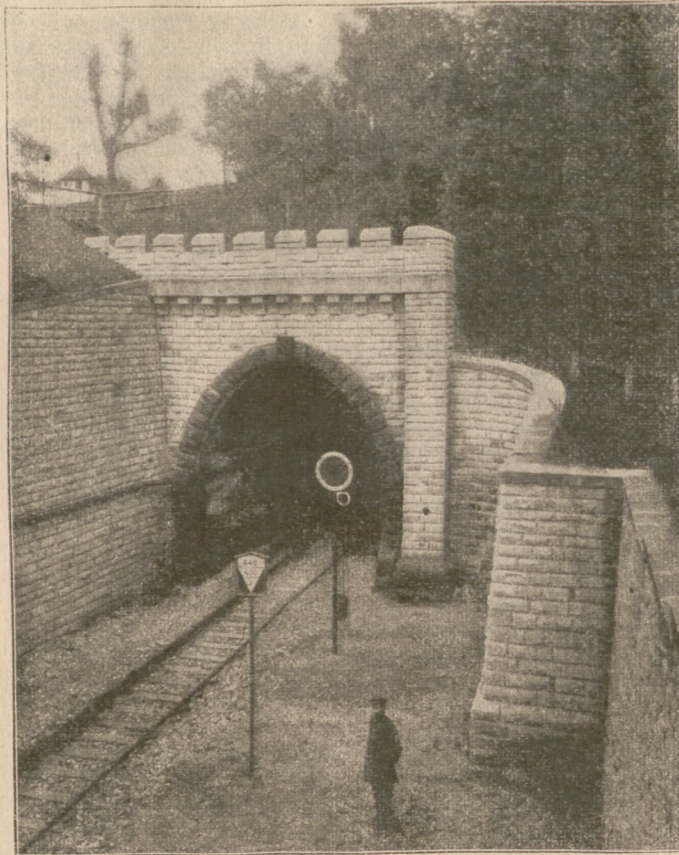
Tunnel bei Heberlingen, Ostportal. (Mit Text.)
