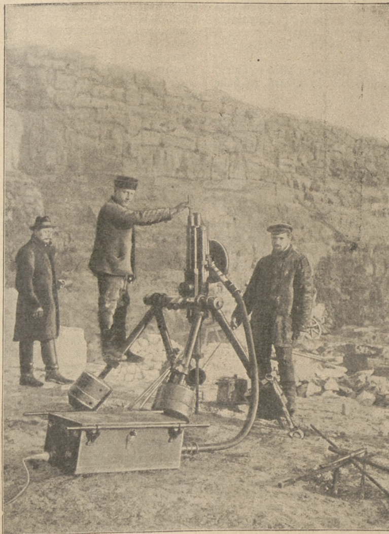
Elektrischer Gesteinbohrer, gerichtet. Photographische Aufnahme. (Mit Text.)
