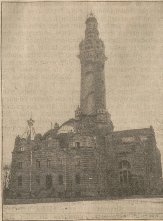
Das neue Fernheizwerk in Dresden. (Mit Text.)
