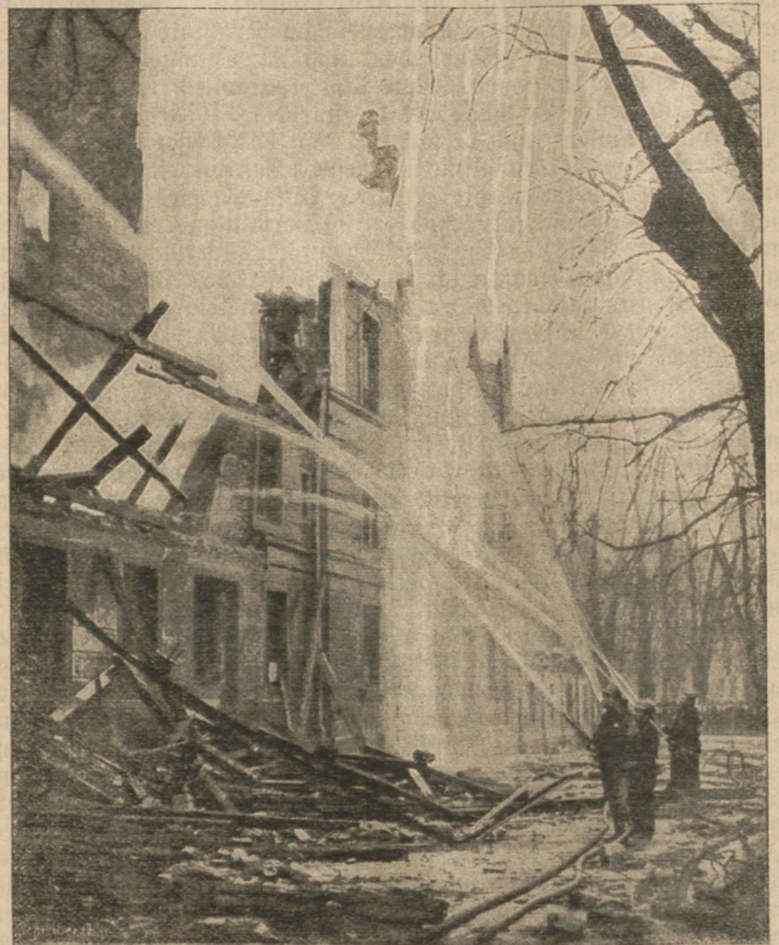
Hoftheater zu Stuttgart (rechte Seite) nach Einsturz der Seitenwand.
