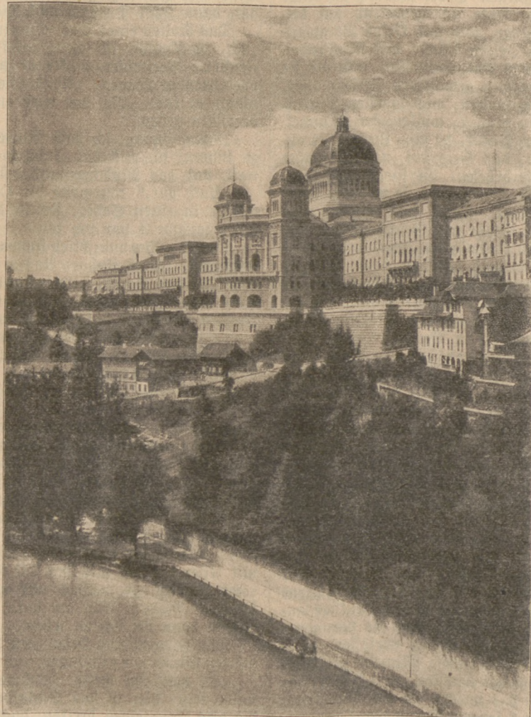
Das neue Bundeshaus in Bern (Gesamtansicht der Südfront). (Mit Text.)
