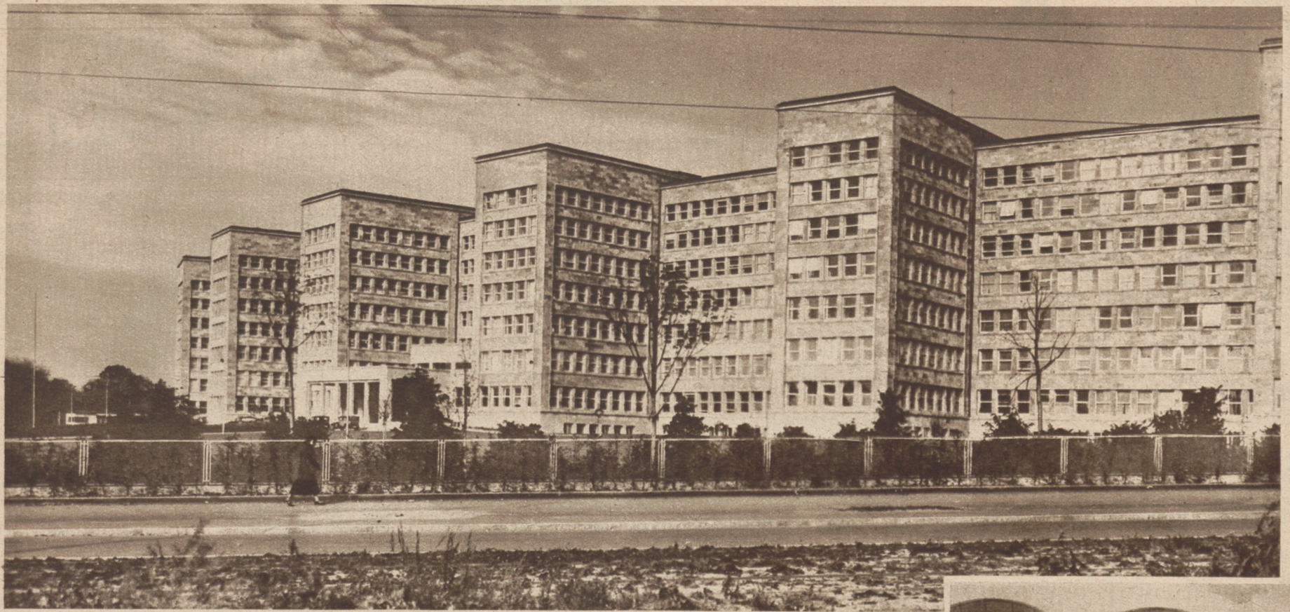
Das gigantische Verwaltungsgebäude eines Industriekonzerns in Frankfurt a. M.
