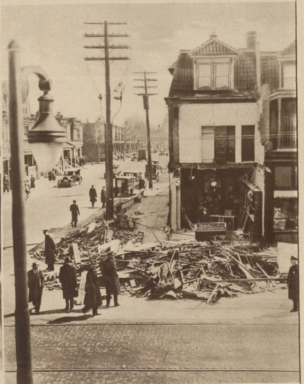
Hauseinsturz durch Autounglück. In Philadelphia fuhr bei einem Autozusammenstoß ein Wagen den Stützpfeiler eines Hauses um, so daß das Haus zusammenstürzte. — Nach dem Zusammenstoß.
