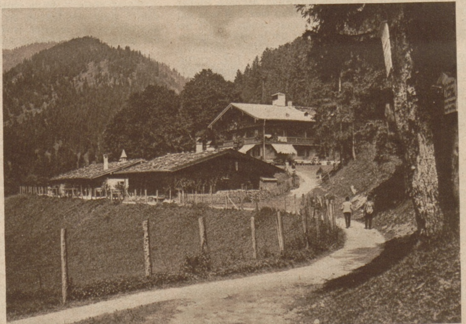
Das Forsthaus der Valepp mit den Nebengebäuden. Links Fremdenstallung, rechts die Winterbehausung der Holzknächte.
