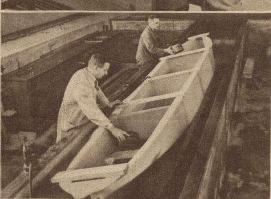
Das unter Wasser aufbewahrte Schiffsmodell aus Paraffin wird ausgeschöpft und für den Schleppversuch hergerichtet.
