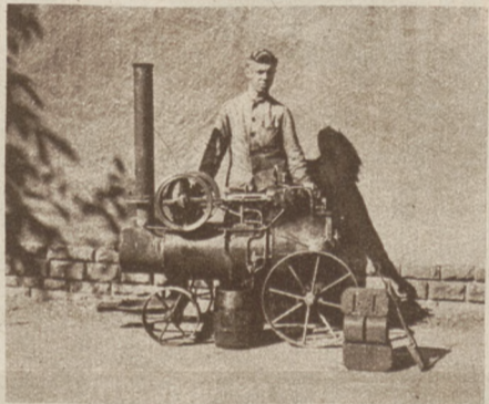
Ein tüchtiger Lehrling. Der Gelbäckerlehrling Hans Feuert aus Neuhaldensleben, Bez. Magdeburg, 16½ Jahre alt, baute diese Lokomotive nach eigenen Zeichnungen während seiner Freizeit. Der junge Mann brauchte dazu rund 1000 Arbeitsstunden. Die Maschine leistet 2½ PS und treibt gleichzeitig eine Kreissäge und eine Lichtmaschine. Ihr Gewicht beträgt 6 Zentner. Das Rohmaterial bestritt der fleißige junge Mann aus seinen Ersparnissen. Die Lokomotive wird demnächst auf einer Ausstellung in Magdeburg gezeigt.
