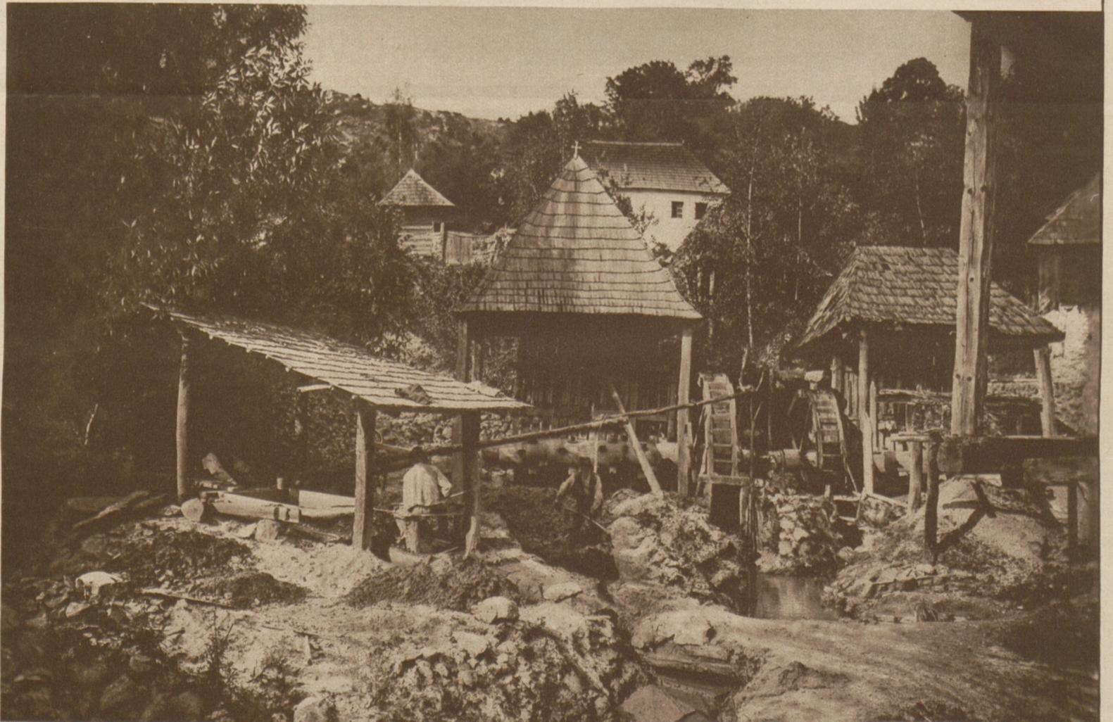
Durch Wasserkraft betriebene „Stampfer“, die das goldhaltige Erz zu einem mehlartigen Brei zerstampfen, wobei das Gold dann durch Auswaschung gewonnen wird.
