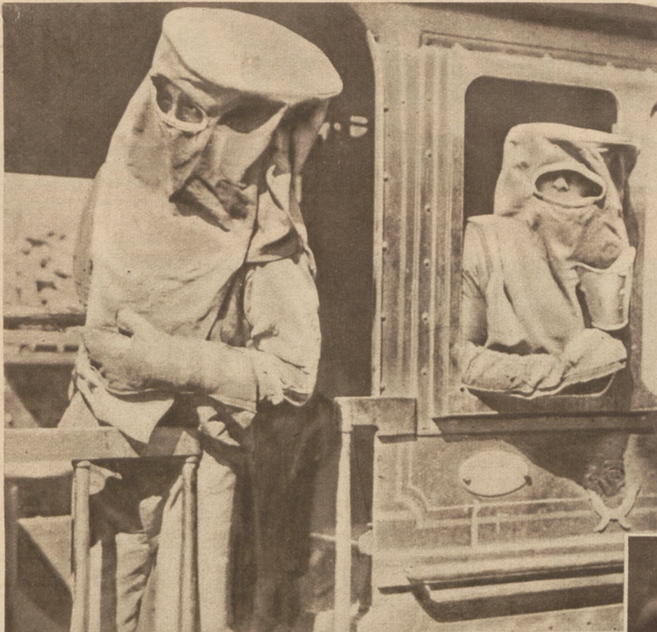
Sicherheitsmasken für Lokomotivführer gegen Gas- und Rauchvergiftungen.
