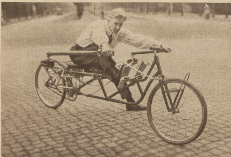
Das „Radomobil“, ein Trainings- und Sportfahrzeug, ist ein Fahrrad, das durch Ruderbewegungen angetrieben und durch Fußsteuerung am Vorderrad gelenkt wird.
