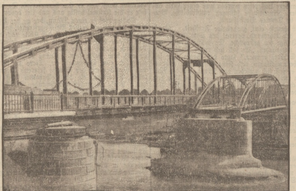
Die neue Elbbrücke in Torgau wird eingefahren
