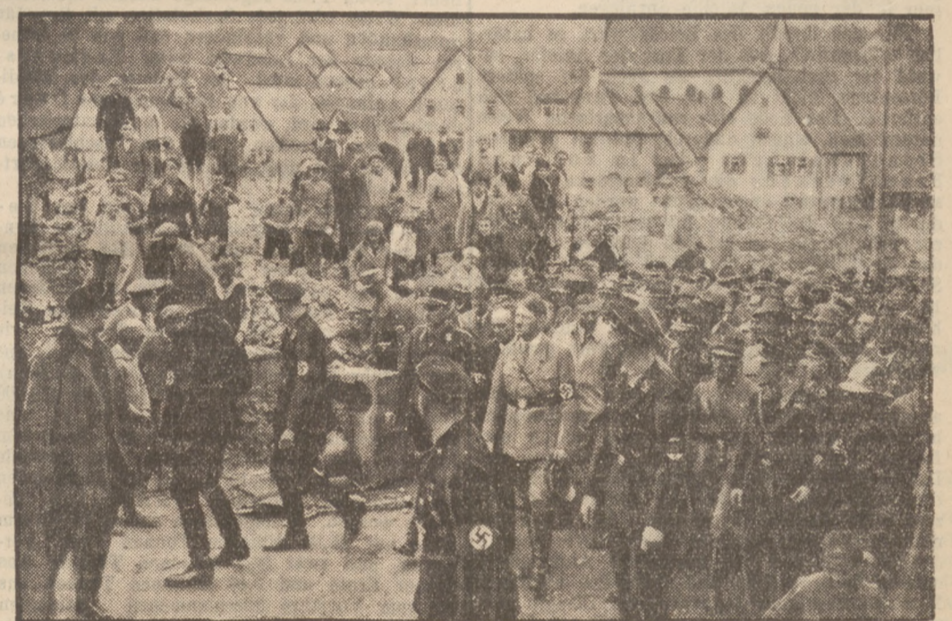
Der Führer besichtigt die Trümmer von Deschelbronn
