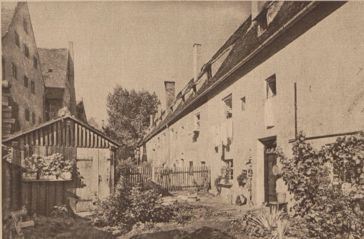
Rückseite eines Siedlungshauses.
