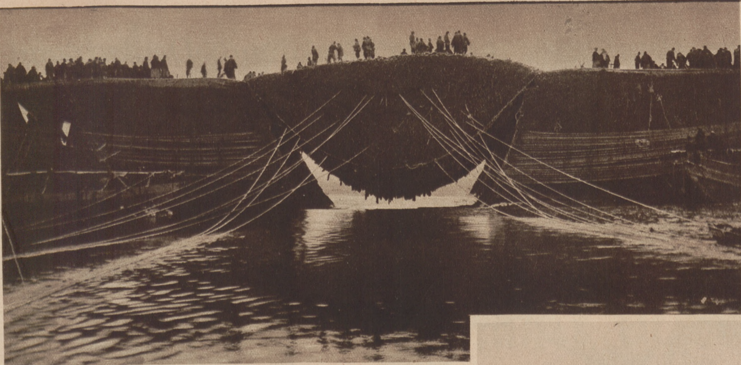
Das mit Erde gefüllte Flechtwerk senkt sich und verschließt die Bruchstelle im Damm.
