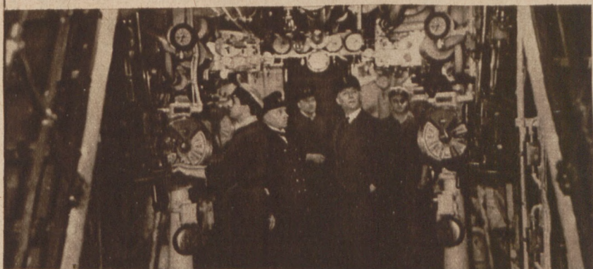
Im Haupt- kontrollstand des Maschinen- raums.
